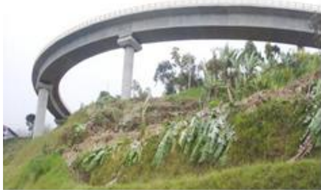
FIGURA 4. Puente Helicoidal parte del proyecto Autopista del Café, Colombia. Fuente: http://www.eldiario.com.co/seccion/REGIONAL/el-s-bado-inauguran-el-puente-helicoidal100714.html
