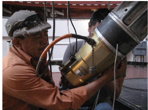
FIGURA 9. Acoplando el espectrógrafo Boller & Chivens al telescopio de 1m.
